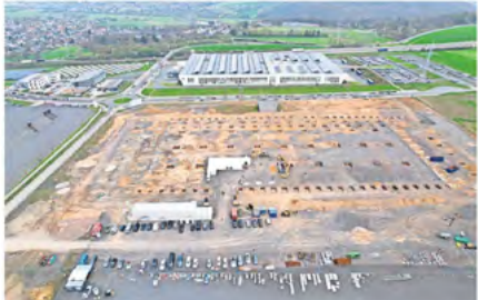
Von links nach rechts: Die SMA Gigawatt-Factory in Niestetal, die SMA Gigawatt-Factory in Niestetal, die SMA Gigawatt-Factory in Niestetal.
