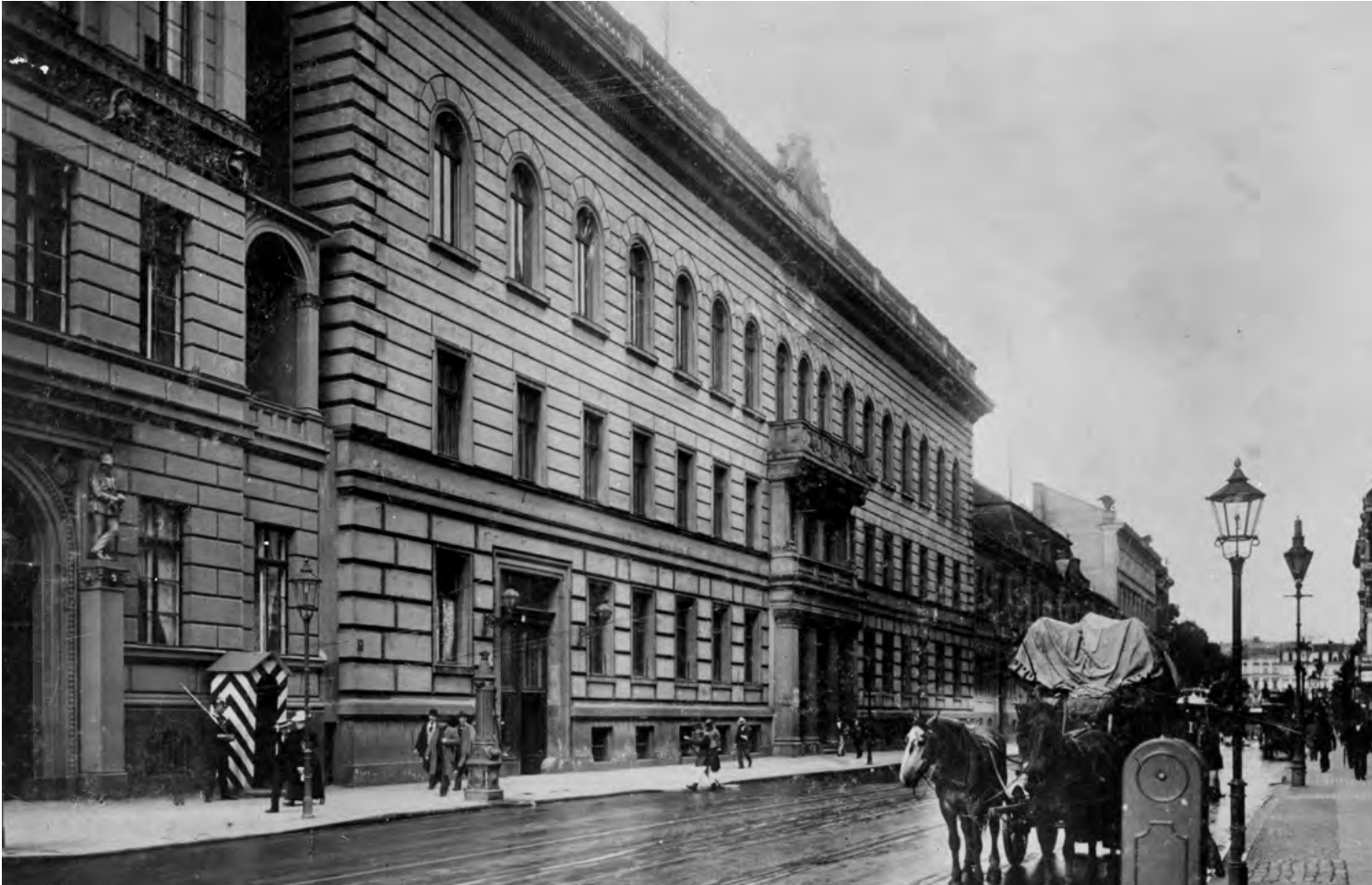
Berlin 1898: Das alte Reichstagsgebäude an der Leipziger Straße 4. Von 1871 bis 1894 war es Sitz des Reichstags. 1898 – kurz nach dieser Aufnahme – musste es dem Neubau des Herrenhauses weichen.
