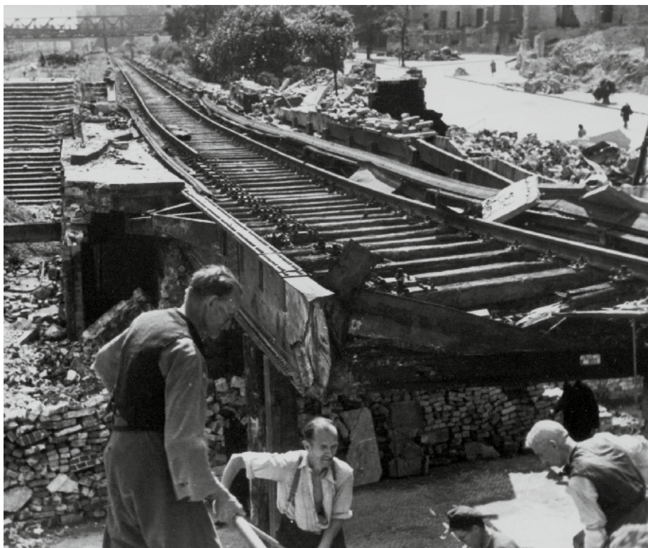
Nach dem Zweiten Weltkrieg lag auch der Eisenbahnverkehr am Boden. Die Gleise musste in Handarbeit instand gesetzt werden. Der Wiederaufbau dauerte bis weit in die 50er-Jahre.
